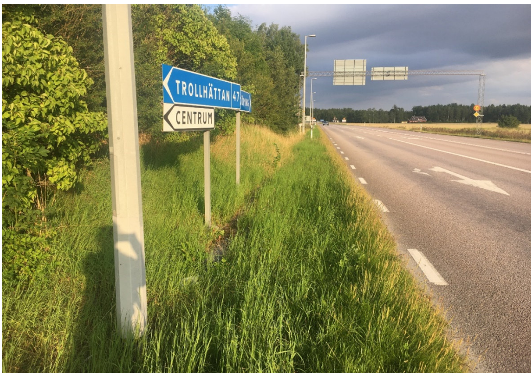
Fig 4 Befintligt vägdike längs väg 47. Diket som följer väg 47s norra väggkant, i riktning mot Mjölån. Vägplanen innebär att diket i delar tas bort och ges ny riktning och läge.
