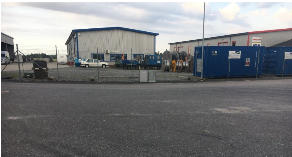
Fig 7 Vändplanen och lågpunkten, sänkan vid rinnväg C (industriområdet). I mitten finns en gallerbrunn för dagvatten. Rinnvägen följer Plogvägens fortsättning åt öster det vill säga åt höger i bilden.
