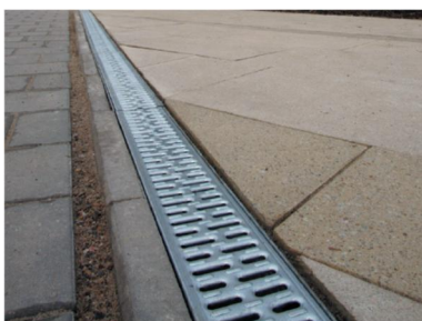
Figur 12 Ytavrinningsränna för avledning av medelstora regn. Källa: aco-nordic.se
