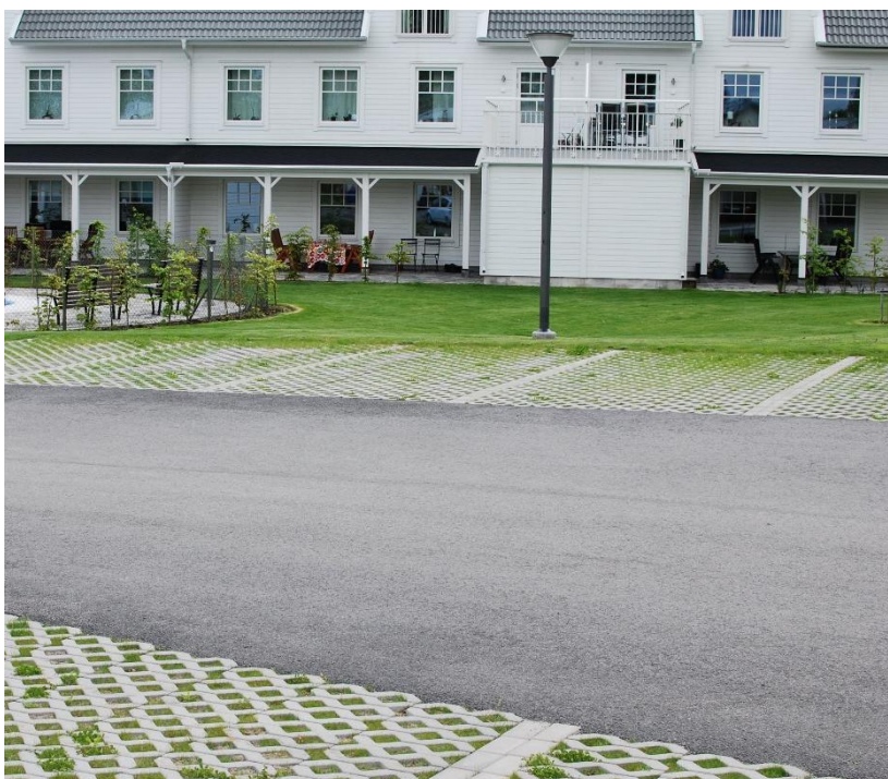
Figur 11 Gräsarmering i betong på parkering. Foto: Sweco
