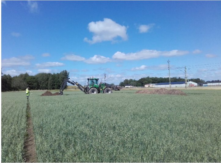
Fig. 22. Översikt schakt vid L1963:2882. Foto från öst.
