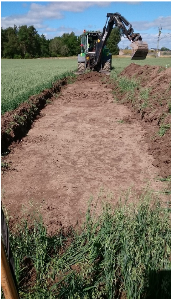
Fig. 23. Schakt 575 vid L1963:2882. Inget av intresse fanns i schakten vid lämningen. Foto från öst.
